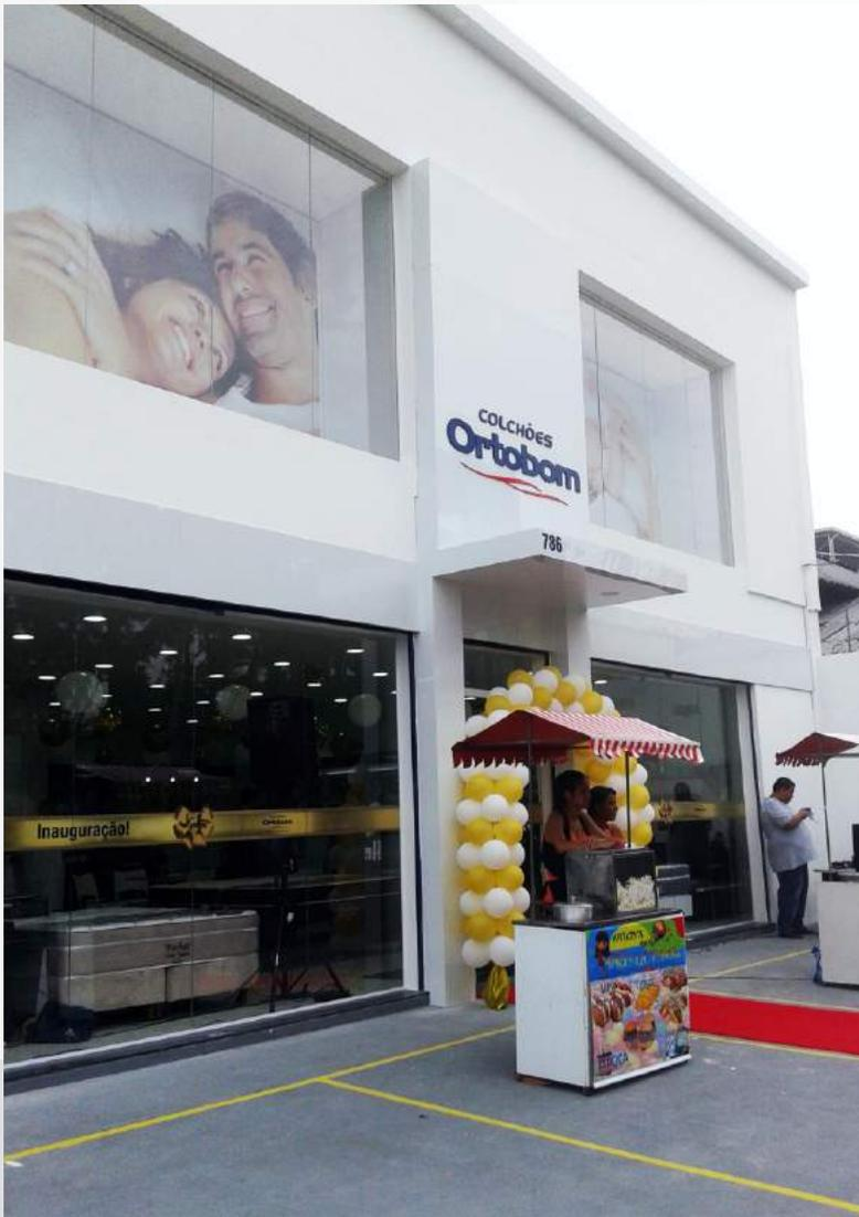
Portal em ACM com letras relevo em PVC Expandido 10mm com spots de iluminação + adesivo fosco no interior da vitrine
